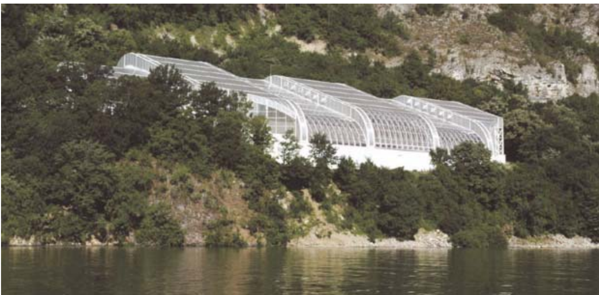
Radovi na rekonstrukciji koštali 342 miliona dinara -Foto D. Karadarević
